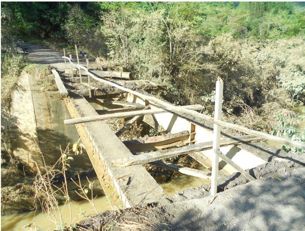
Estrutura da ponte em perfil metálico – capacidade de carga 45 ton.
