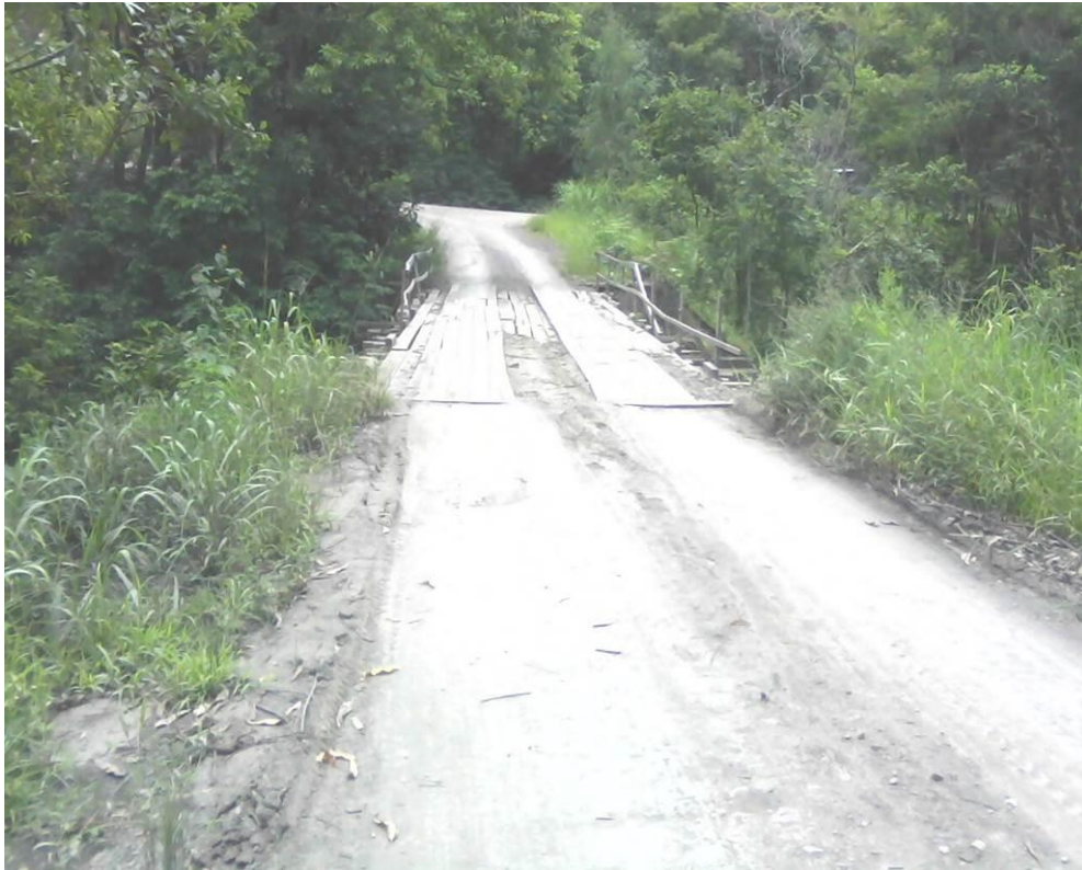
Ponte atual. Construção improvisada para atender a comunidade.
