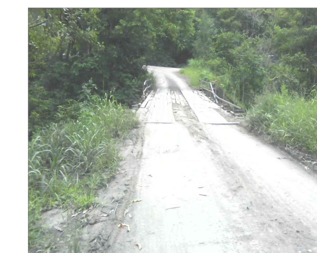
Ponte com pista em madeira - caráter emergencial
