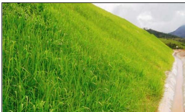
Figura 17.3 – Proteção de talude com hidrossemeadura.
