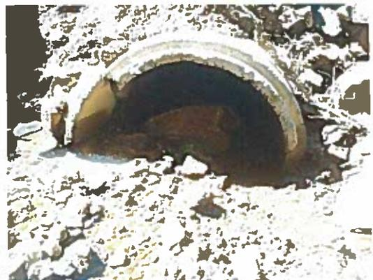
Primeiramente neste ponto, a equipe em vistoria verifica o **estado de funcionamento da drenagem corrente**, a **suficiência das seções de vazão dos bueiros**, sua **ausência**; e também o aspecto **“manutenção”**. Note-se na imagem anterior o estado de falência do bueiro quase que completamente assoreado por solo transportado.
