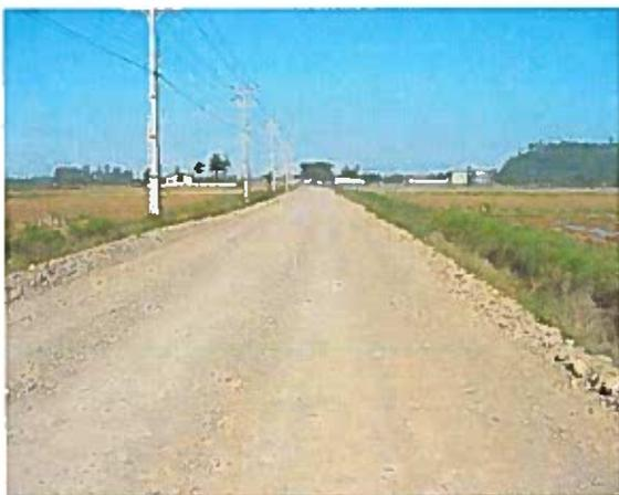
Sua **plataforma** possui gabarito de seção transversal em **larguras compatíveis ao tráfego local**; (ii) As **faixas de trânsito** estão **adequadamente revestidas** com revestimento primário de boa qualidade; e; (iii) A **drenagem** foi **adequadamente implantada**, permite o livre fluxo das águas correntes de contribuição e a drenagem superficial pouco afeta as condições operacionais da pista de rolamento.
