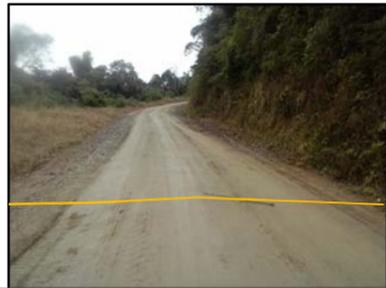
1+848 - Manter BSTC D=0,60m; Comprimento = 12,00m; Executar Caixa a montante e boca a jusante; Executar enrocamento com pedra de mão arrumada; Executar proteção vegetal com 12 mudas de árvores locais e dissipador de energia com pedra arrumada; Classificação do material com escavação em solo;
