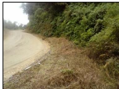
1+635 a 1+700 - LD - Executar vala lateral para condução de água; comprimento = 65,00m;
