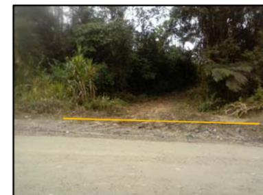
1+608 a 1+616 - LD - Executar travessia com tubo de Ø60; Comprimento = 8,00m;
