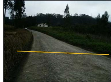
0+000 a 1+420 LE e LD - Regularização de pista e Revestimento primário com saibro de 0,05 cm a executar;
