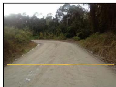
1+600 - Manter BSTC D=0,60m; Comprimento = 12,00m; Executar Caixa a montante e boca a jusante; Executar enrocamento com pedra de mão arrumada; Executar proteção vegetal com 12 mudas de árvores locais e dissipador de energia com pedra arrumada; Classificação do material com escavação em solo.
