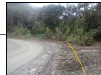
1+590 a 1+600 - LD - Executar travessia com tubo de Ø60; Comprimento = 10,00m;
