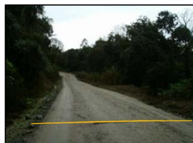
1+493- Executar BSTC D=0,60m; Comprimento = 12,00m; Executar caixa a montante e boca a jusante; Executar enrocamento com pedra de mão arrumada; Executar proteção vegetal com 12 mudas de árvores locais e dissipador de energia com pedra arrumada; Classificação do material com escavação em solo.
