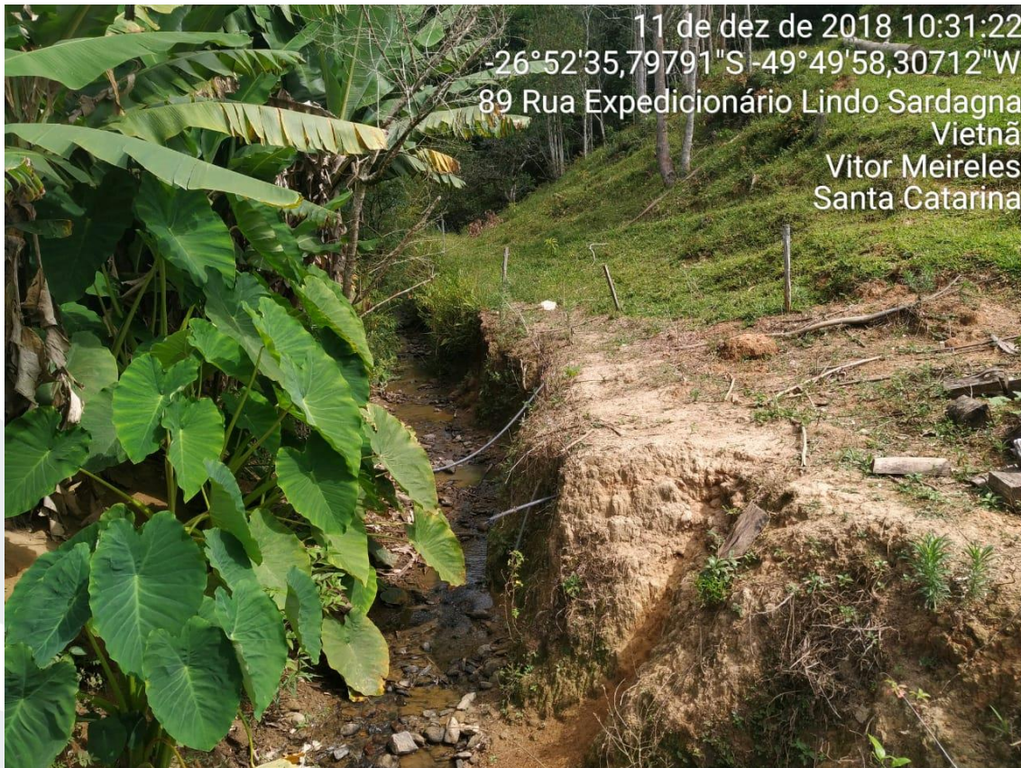
Figura 1 – Início de tubulação de corpo hídrico.
