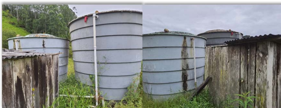
Figura 11 – Reservatórios existentes atualmente
